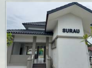
Terdapat kemudahan surau yang disediakan untuk beribadah
